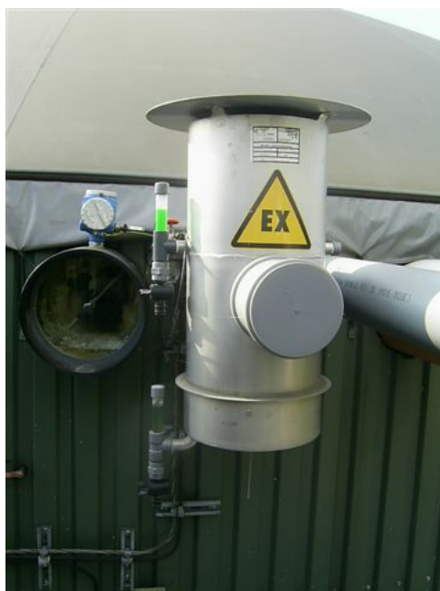
Exemple de soupape de sécurité. Source : Bio-Nrj.
