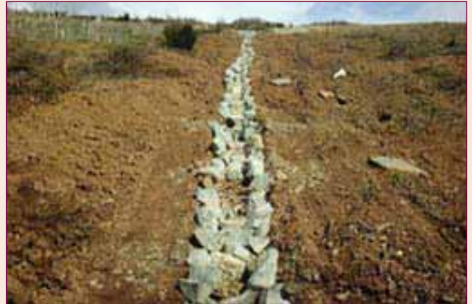
Lors de la replantation, les passages d'eau sont organisés en fonction de la topographie.
