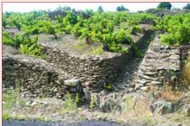
Détail de collecteurs utilisant des pierres sèches
