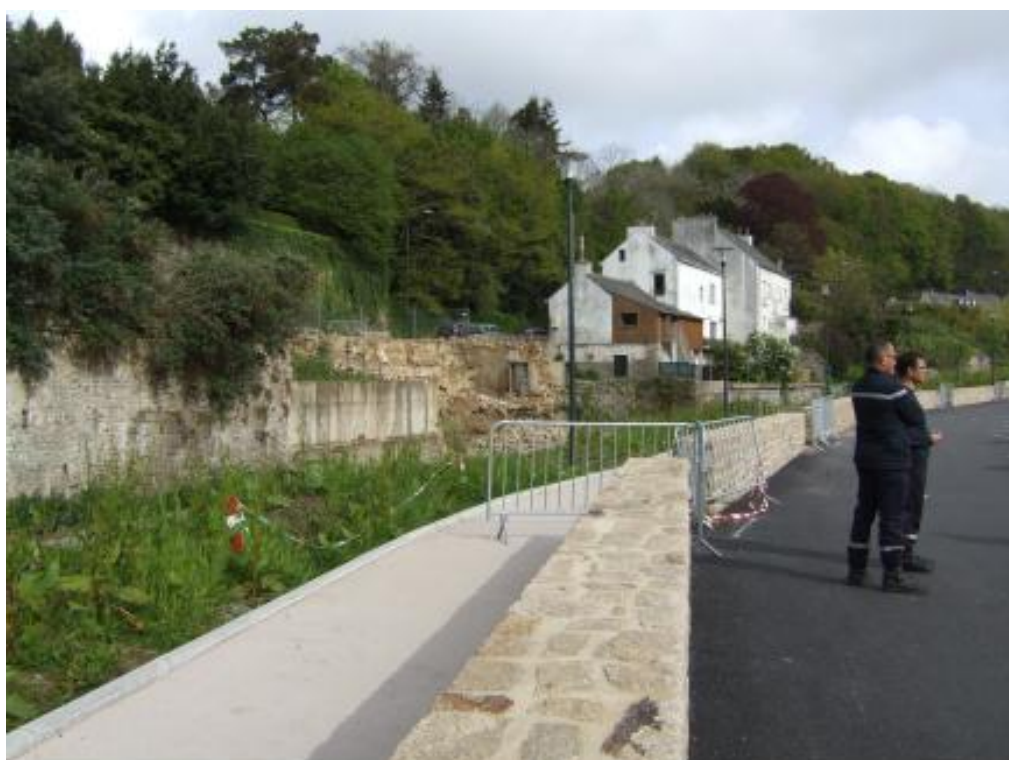
Photo 3 Ruines d'une bâtisse sur les berges de l'Issole, démolie au moment de la tempête Dirk (face au parking Sainte-croix)
