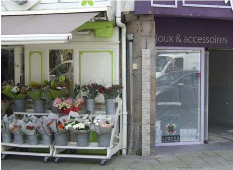
Photo 5 Morlaix, entre 2 commerces place des Otages : un repère de crue qui ressemble davantage à une échelle de crue.
